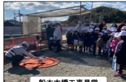
船木大橋工事見学
